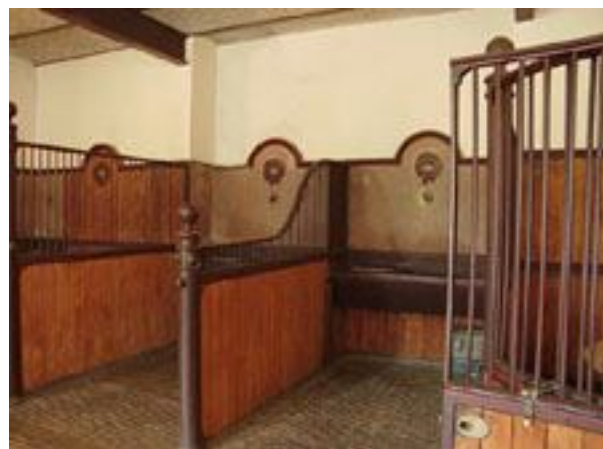
Les stalles des écuries de Château de la Bretonnière. Les mangeoires et abreuvoirs sont individualisés.
