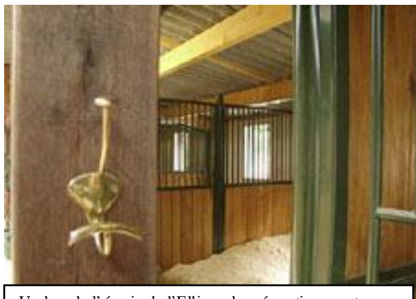
Un box de l'écurie de l'Ellipse, les séparations sont ajourées en partie haute.
