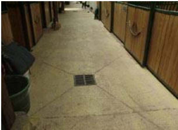
Le sol des écuries de l'Ellipse est simplement fait en béton, avec des formes de pente pour évacuer les liquides directement vers les canalisations.
