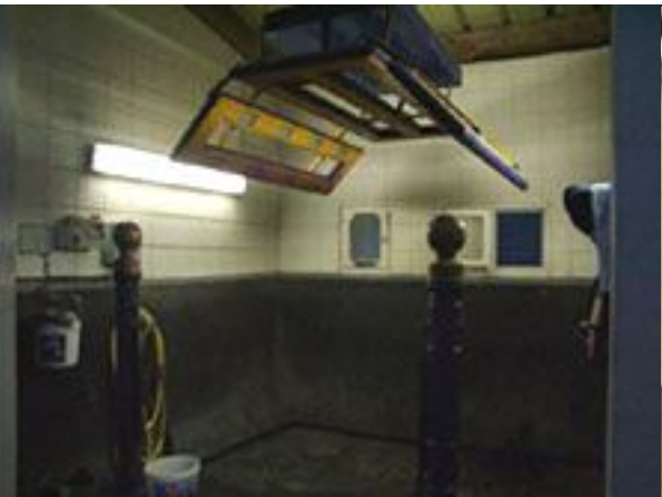
Lampes ultraviolettes de l’écurie du baron de Rothschild, on note les poteaux permettant d’attacher les chevaux, ainsi que les caoutchoucs sur les mur pour protéger les chevaux s’ils venaient à taper sur les parois. Ici une douche est associée aux lampes.
