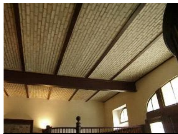
Le plafond des écuries de la Bretonnière est constitué de voûtains entre les poutres.
