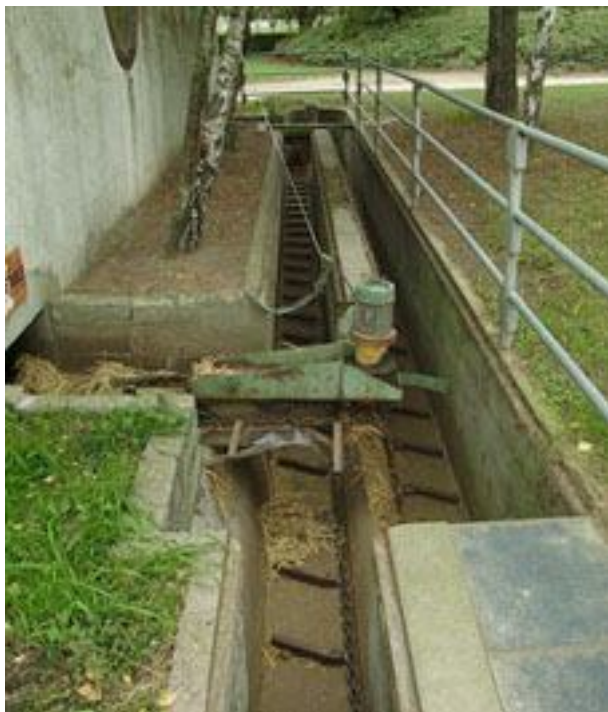
Le couloir de service des écuries de l'ENE, et le système d'évacuation des fumiers
