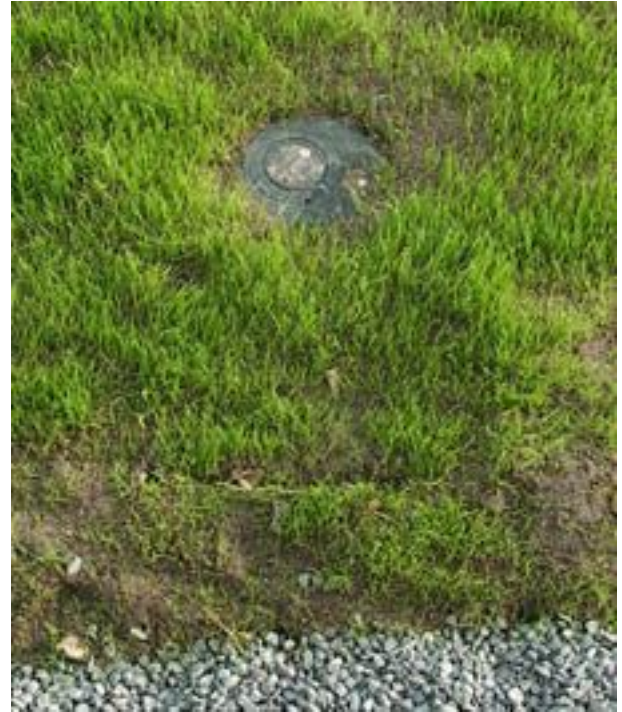
Le sol en herbe sablé du terrain de concours de la Baule, avec une des buses du système d'arrosage enterré.
