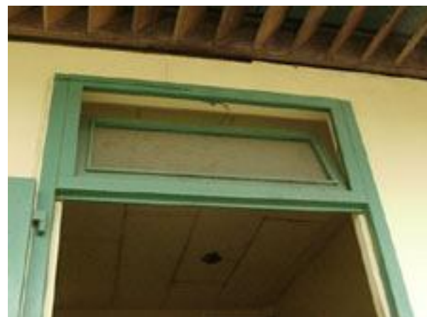
Fenêtre pivotante au dessus d'une porte de box, à l'ENE.
