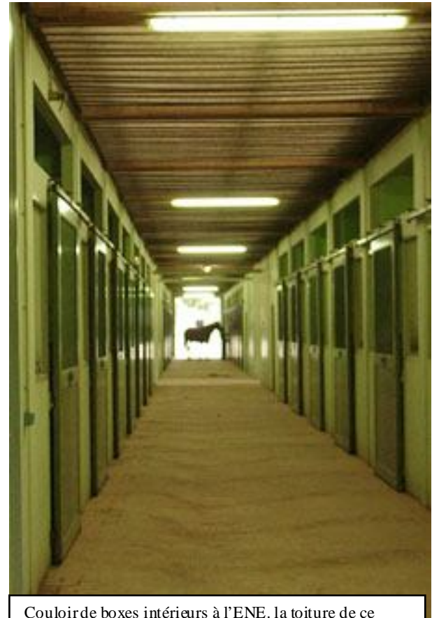
Couloir de boxes intérieurs à l'ENE. la toiture de ce couloir est partiellement vitrée, mais des lames de bois pare-soleil viennent complètement obscurcir la circulation, obligeant le recours à la lumière artificielle en plein jour !
