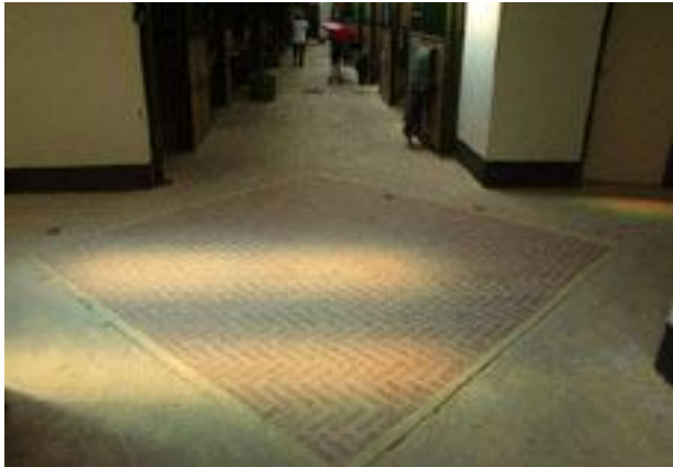
Le sol de l'écurie de l'Ellipse est agrémenté de rappel aux anciens sols, grâce à l'utilisation de briques aux croisements des circulations.
