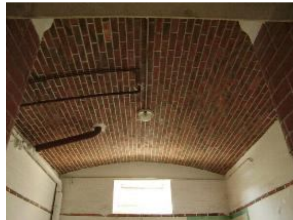
Chaque box du Haras de Gâtine est voûté avec un appareillage de briques.
