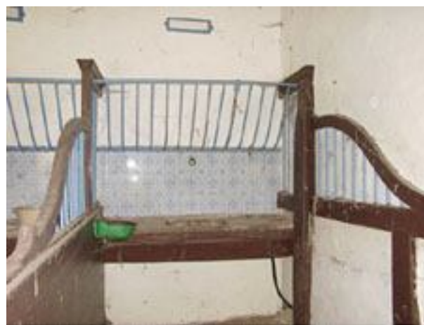
Une stalle des écuries du Château de Saint-Thomas, avec les séparations à col-de-cygne comme décrit par Gayot.
