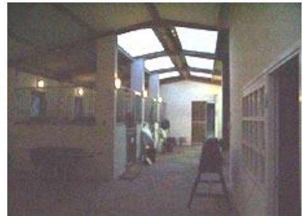
Les écuries du baron de Rothschild ont un volume trop important, chaque cheval a un certain volume d'air, mais les boxes ouverts sur la circulation font qu'il faut y ajouter ce volume, d'où des problèmes d'aération.
